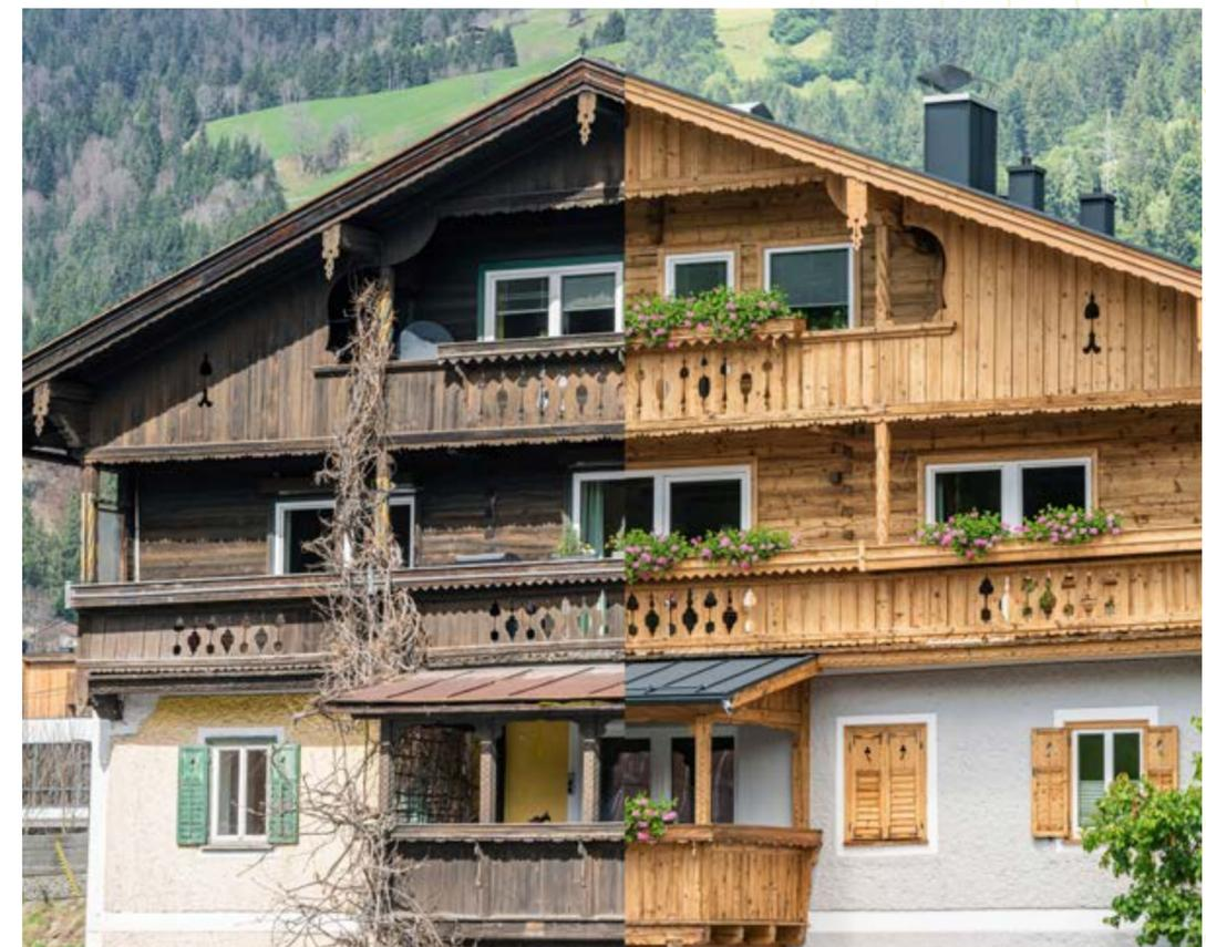
Holzhäuser erstrahlen in neuem Glanz durch das SWARCOBLAST Strahlglasgranulat. Links: Vor der Oberflächenbehandlung, rechts: Nach der Oberflächenbehandlung. Fotocredit: Strahltechnik Lechner GmbH
